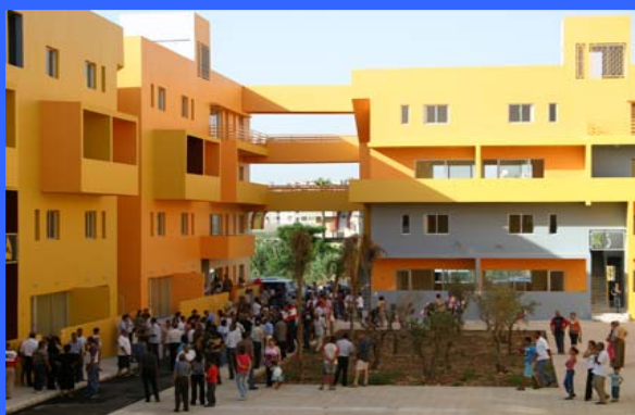
Construcción de viviendas para pescadores de la cooperativa AlBaqa Líbano
